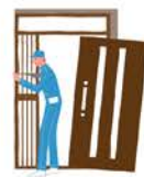
新しいドア枠の取付け、 本体を吊りこむ
